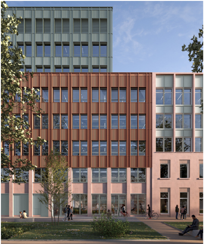
Vue entrée rue Marie Hamm
