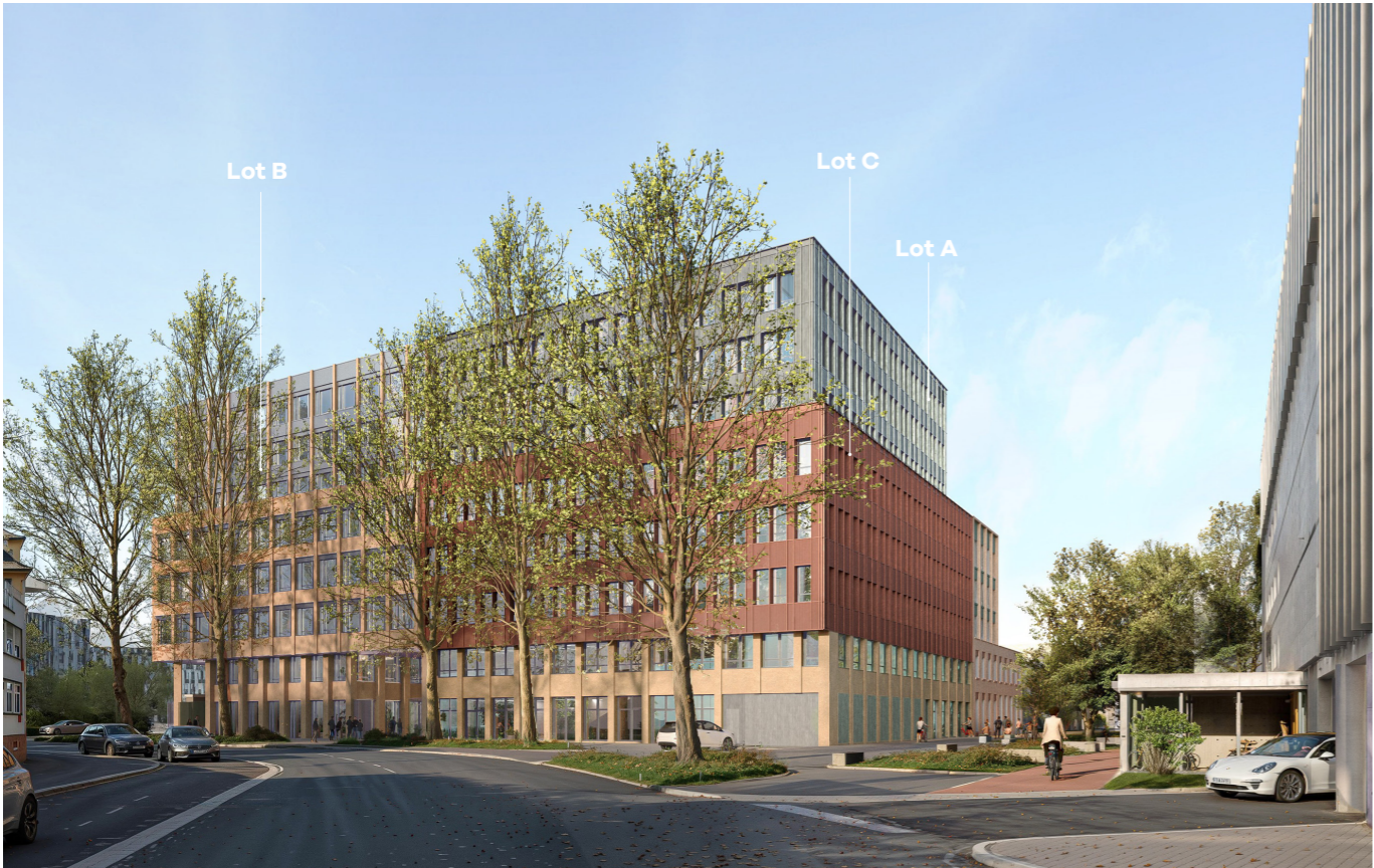
Vue depuis la rue Porte de l'Hôpital
