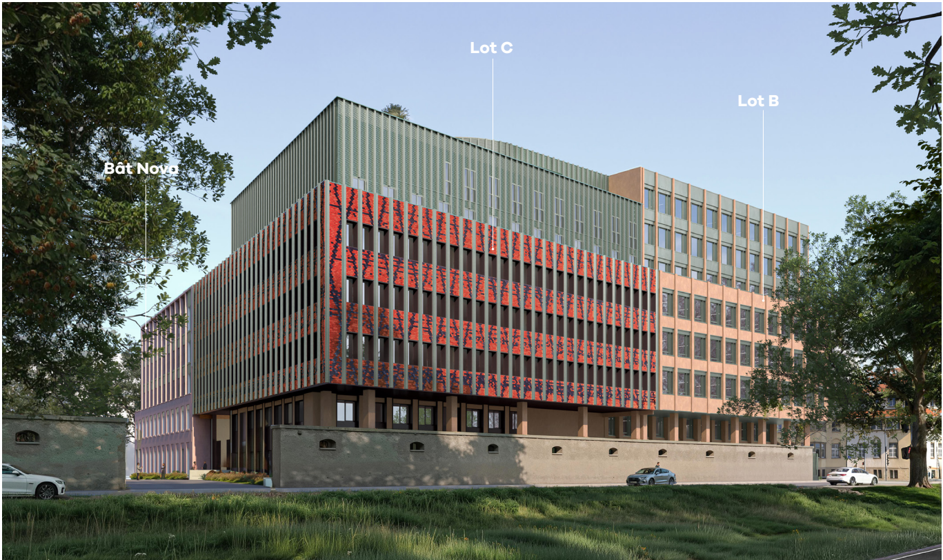
Vue depuis le Quai Taffel
